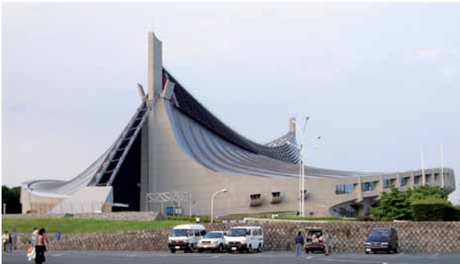
Фото 5. Гимнастический зал в Токио (1964 г.)
