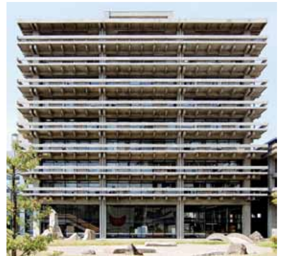
Фото 6. Административное здание префектуры Кагава в г. Такамацу (1958 г.)
